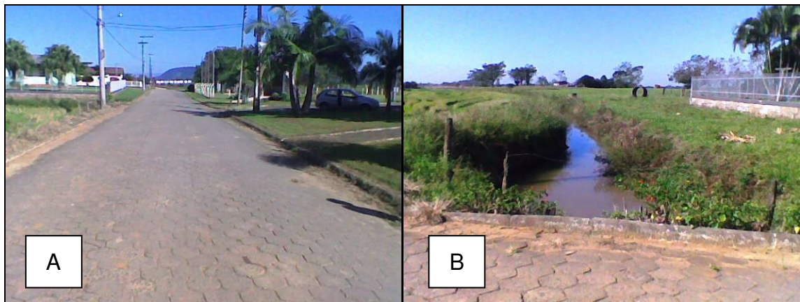
Figura 27 – A) Vista de rua pavimentada; B) Canal de macrodrenagem na Localidade Santa Rosa, maio de 2010.
