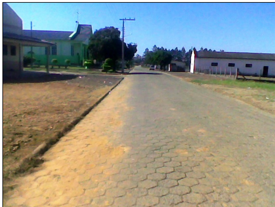
Figura 28 – Rua pavimentada com microdrenagem implantada na Localidade Santa Terezinha, abril de 2010.
