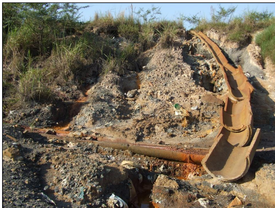
Figura 27 – Vista de talude na área do “aterro controlado”. Forquilha, abril de 2010.
