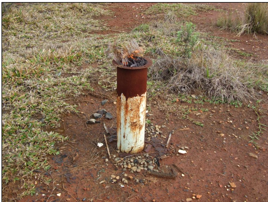
Figura 23 – Dreno de gás do “aterro controlado”. Forquilha, março de 2010.
