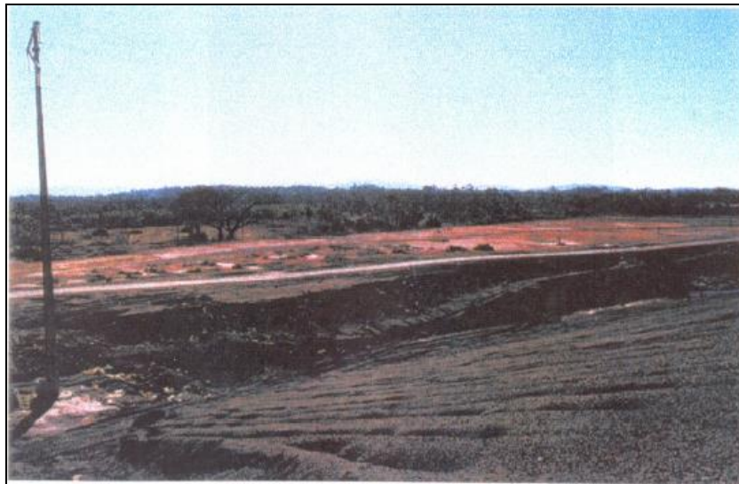
Figura 22 – Vista da 1ª etapa de operação do “aterro controlado” concluída em Julho de 1997. Fonte: UFSC/UNESC, 1997.
