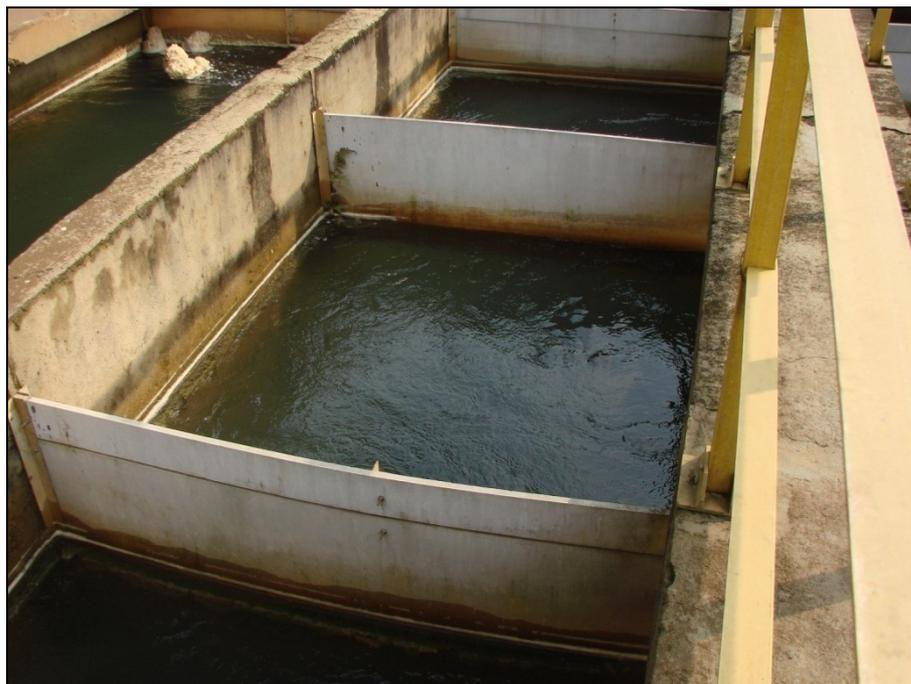
Figura 7 – Detalhe de Floculador Hidráulico.
