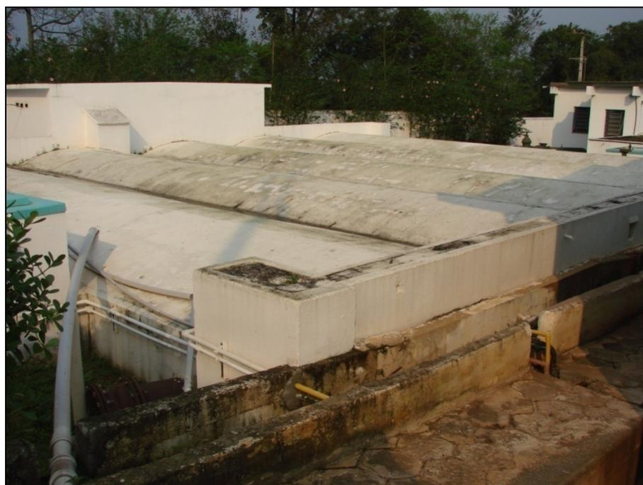
Figura 13 – Detalhe do reservatório de contato (500 m<sup>3</sup>) onde é aplicado flúor, cloro gasoso e cal hidratada para ajuste de pH.
