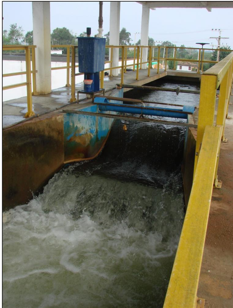
Figura 6 – Detalhe de medidor de vazão e dosagem de sulfato de alumínio.
