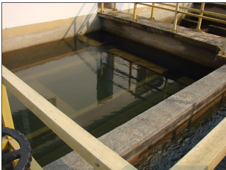
Figura 11 – Detalhe do Filtro Rápido de areia e carvão de dupla camada com ciclo de limpeza em contracorrente.
