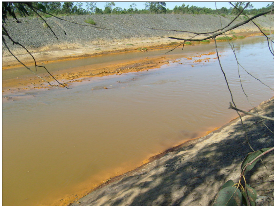
Figura 35 – Assoreamento do rio Sangão com sedimentos de rejeitos, Abril de 2010.
