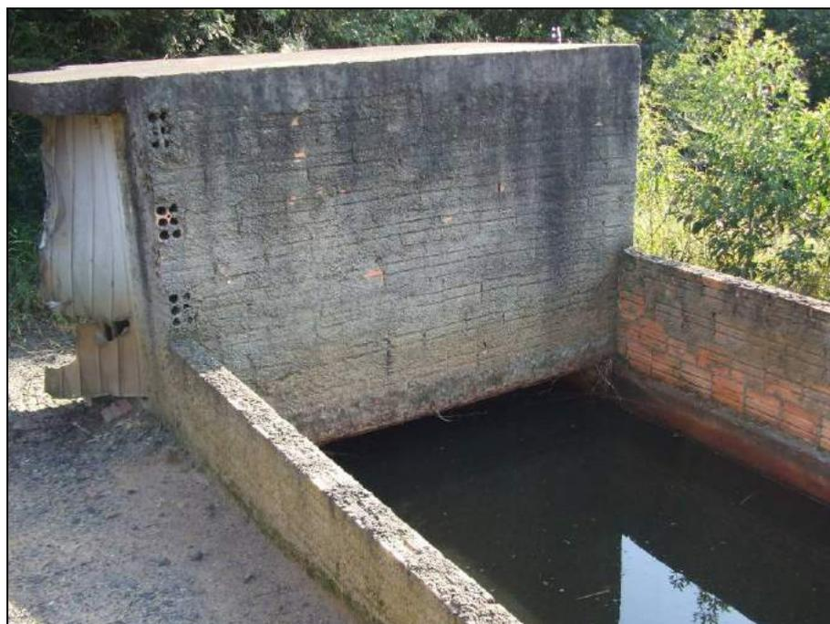
**Figura 31 – Estação desativada de coleta e recalque de chorume para tratamento. Forquilhina, abril de 2010.**
