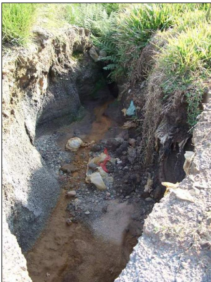
**Figura 30 – Voçoroca provocada pela drenagem de chorume percolado das pilhas de resíduos. Forquilha, abril de 2010.**
