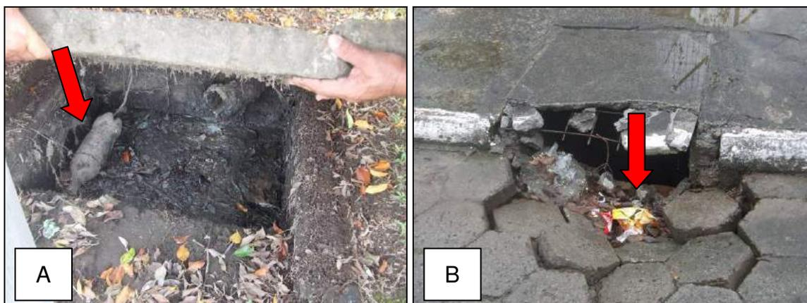
**Figura 49 – A) Aporte de sedimentos, folhas e resíduos recicláveis (no detalhe uma garrafa de plástico) em uma boca-de-lobo; B) Má conservação de boca-de-lobo com carregamento de resíduos recicláveis. Forquilha, Março de 2010.**
