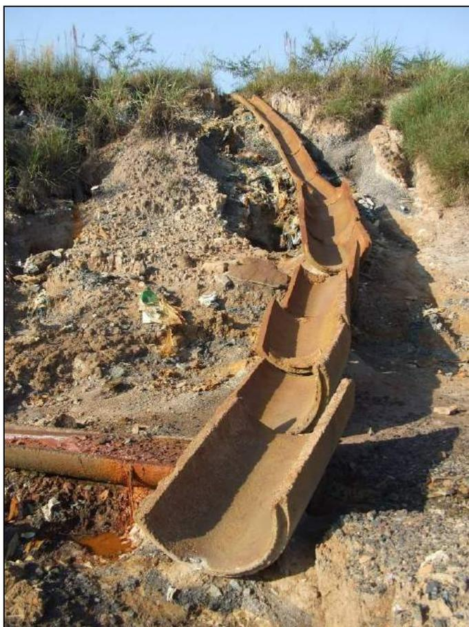
**Figura 26 – Vista de um talude que foi “coberto” por argila, apresentando rejeitos piritosos e resíduos descobertos. No detalhe, uma canaleta de drenagem superficial danificada. Forquilha, abril de 2010.**
